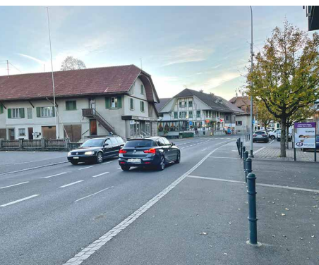
Hauptverkehrsachse durch Uetendorf, die auf Initiative der GRÜNEN neugestaltet werden soll.
